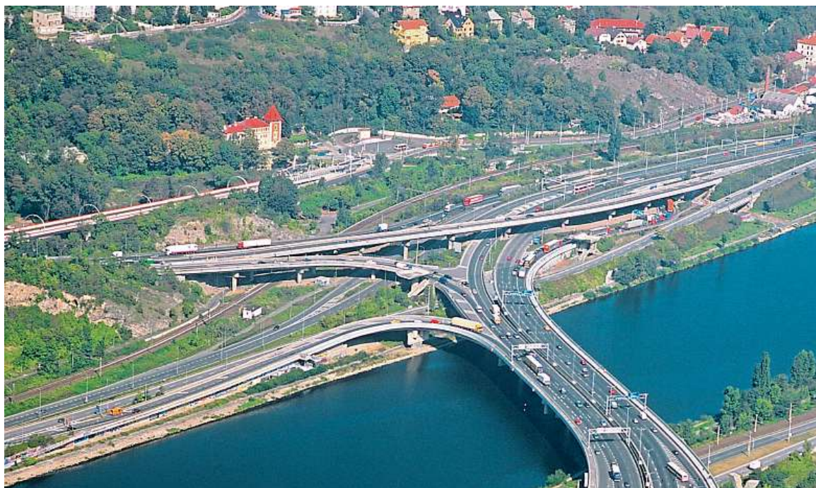
Mega stavba Hlavní oprava Barrandovského mostu potrvá čtyři roky, proběhne v letech 2022 až 2025.
